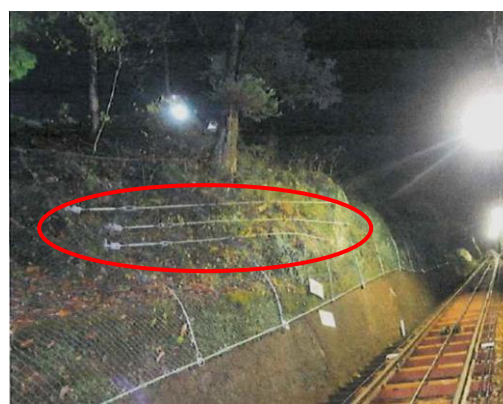
岩盤固定用ロープ設置
