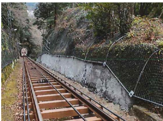
落石防護金網補修
