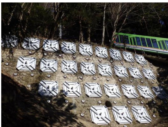
石積擁壁補強
