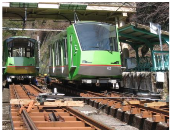
施工中（旧索条撤去）
