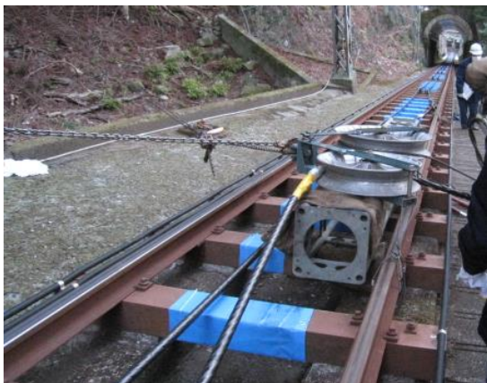
施工中（新旧索条接続・置換）
