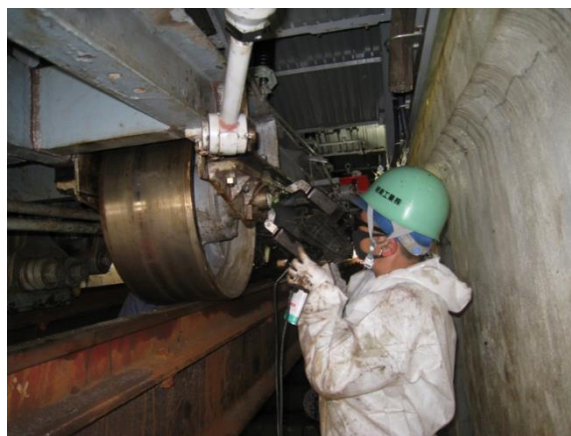
探傷器による探傷
