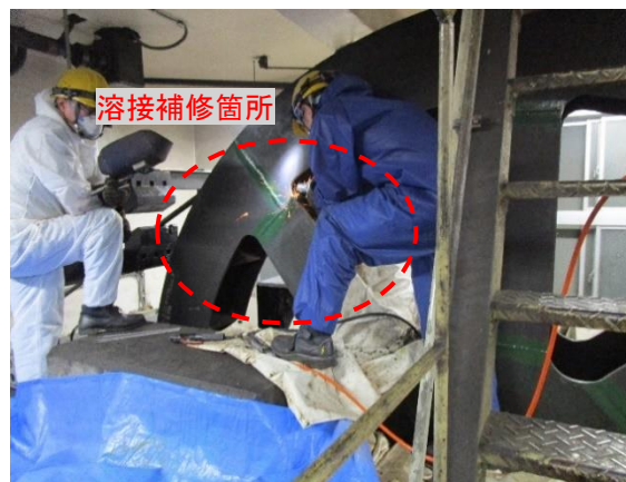
溶接補修作業
