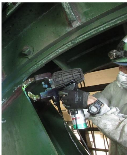
探傷検査作業
