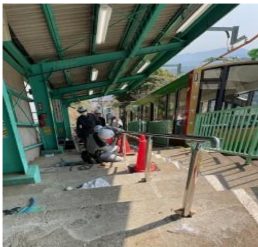
阿夫利神社駅通路区分手摺新設
