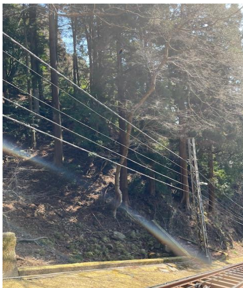
樹木伐採作業施工前
