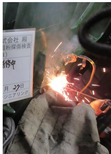
溶接補修作業
