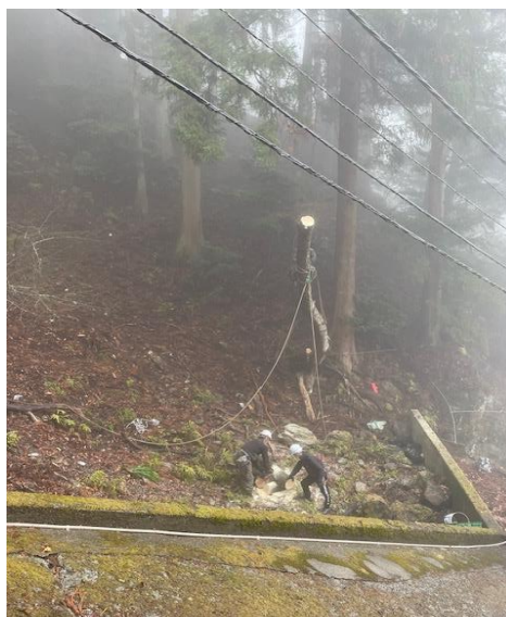
樹木伐採作業中
