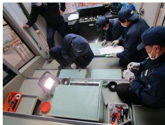
施工中（部品交換）
