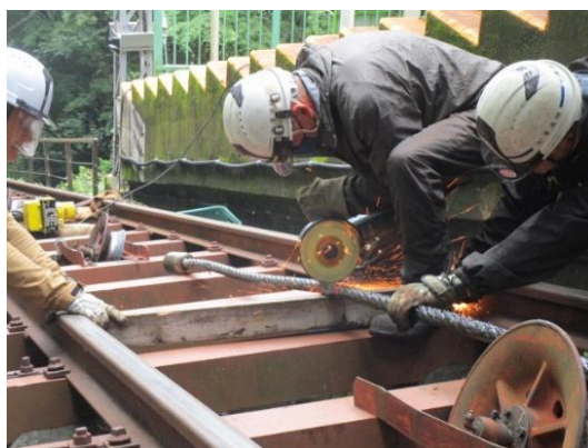
施工中（索条切断）
