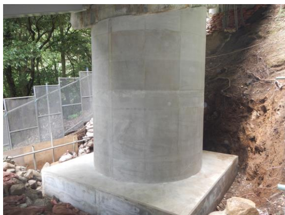
第1 電車橋橋脚補強
