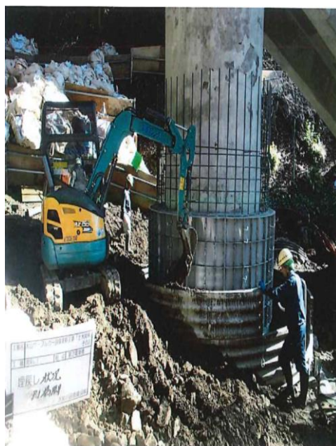
第2 電車橋橋脚補強
