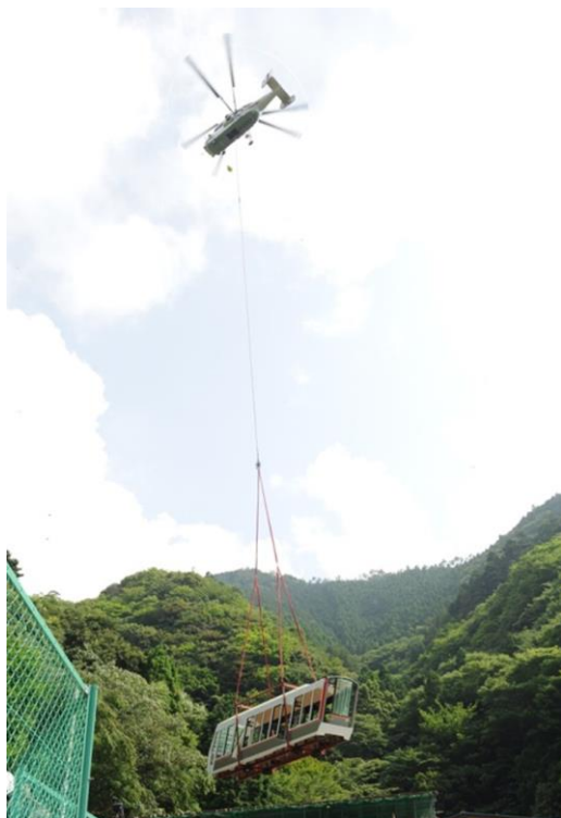
ヘリコプターによる車体搬入
