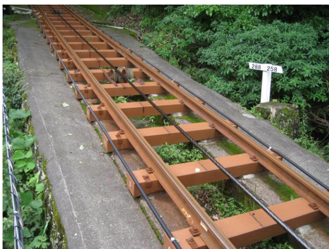
通信用地上アンテナケーブル
