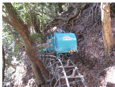
工事用モノレール
