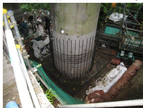
橋脚補強（配筋状況）
