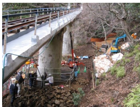
橋脚補強（掘削状況）
