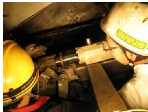
ブレーキ緩解装置更新工事
