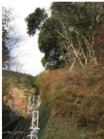
沿線樹木伐採
