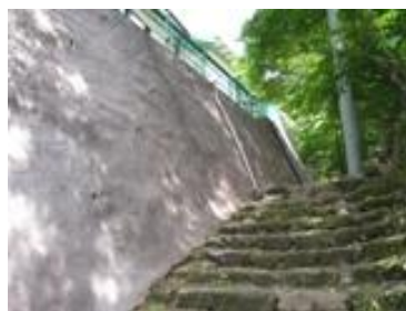
大山ケーブル駅石積み補強
