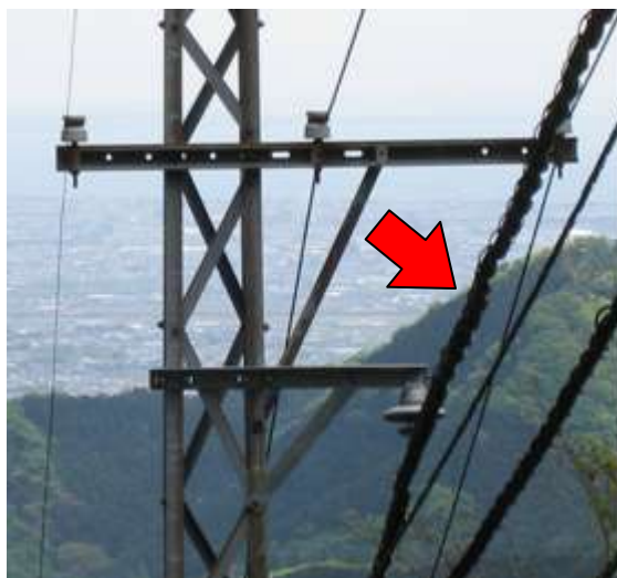
高圧配電線ケーブル化
