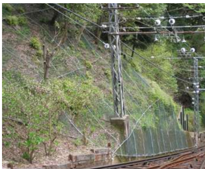
落石防護網新設
