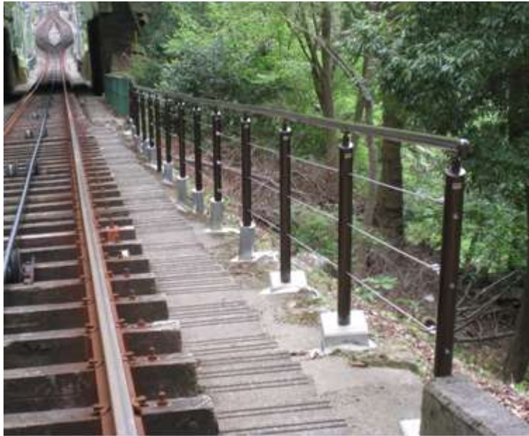
転落防止柵新設
