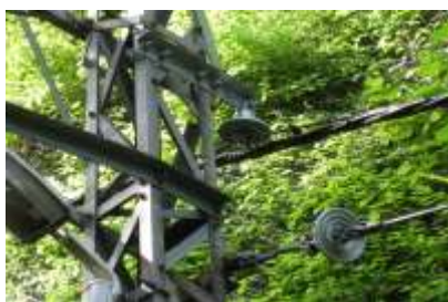
高圧配電線ケーブル化
