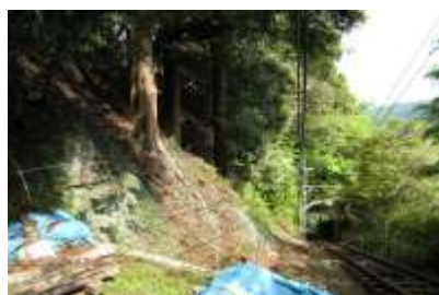
落石防護網新設
